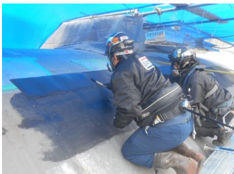
図-1 防寒養生と赤外線ヒータの施工例（参考）
